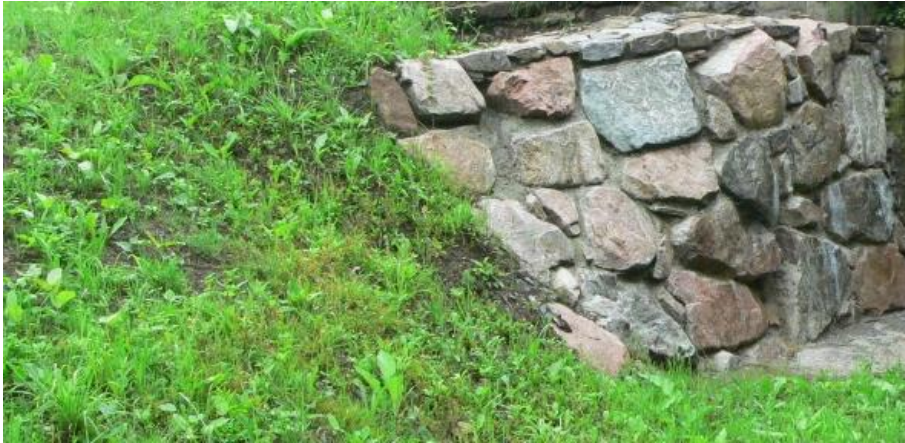
Abbildung 5: Verwinden einer Flügelmauer in eine Böschung
