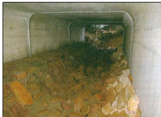
Abbildung 3: Grobstruktur in Betonmatrix (Bielbach/Oberranschütz)
