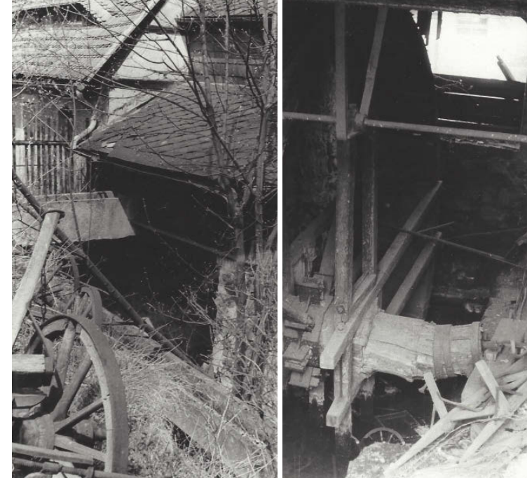
Ansichten der Mühlradstube vor dem Abriß 1986 mit den Beton-Wasserkanälen oberhalb des Rades (links) und dem Mühlrad mit gebrochener Welle (rechts).
