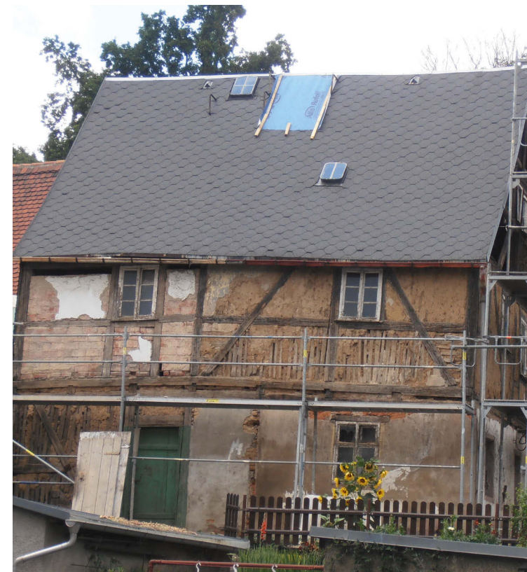
Südseite bei Beginn der Instandsetzungsarbeiten
