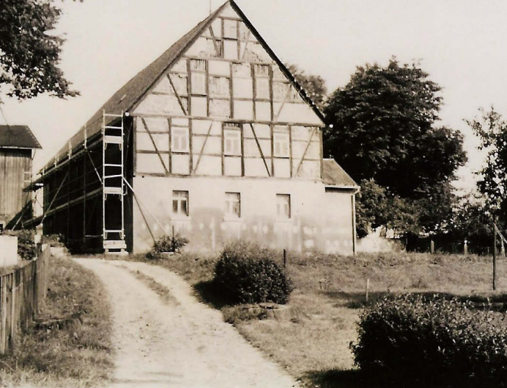
Wohnstallhaus 1985 - erste Sanierungsarbeiten und Umbaubeginn zum Museum
