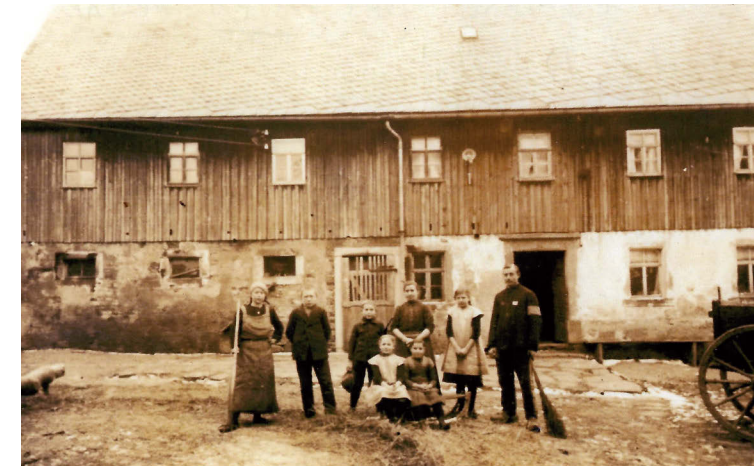
Wohnstallhaus 1917 - die Verbreterung am Fachwerk wurde um 1920 entfernt.
