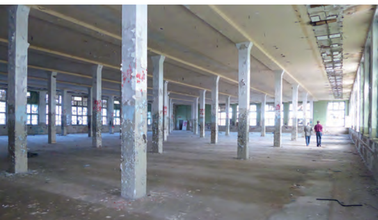
Blick in den einstigen Maschinsaal im ersten Obergeschoss, 2016
